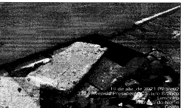
FOTO 12 - TAMPA NO LOCAL
